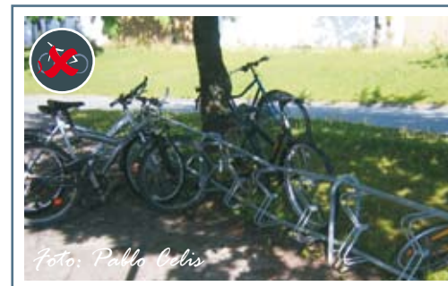
Ikke kileformet forhjulsholder - dur kun til brede dæk, og almindelige cykler vælter nemt.
