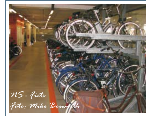
Parkeringen klares med to-etagers stativer med hejse-mekanisme.
