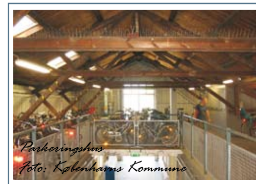
Parkeringshus Foto: Københavns Kommune Øvre etage i banegården udnyttes til cykelparkering.
